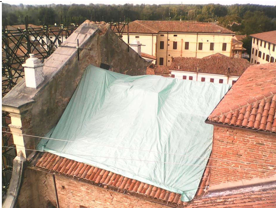
Posa di telo di protezione in copertura
