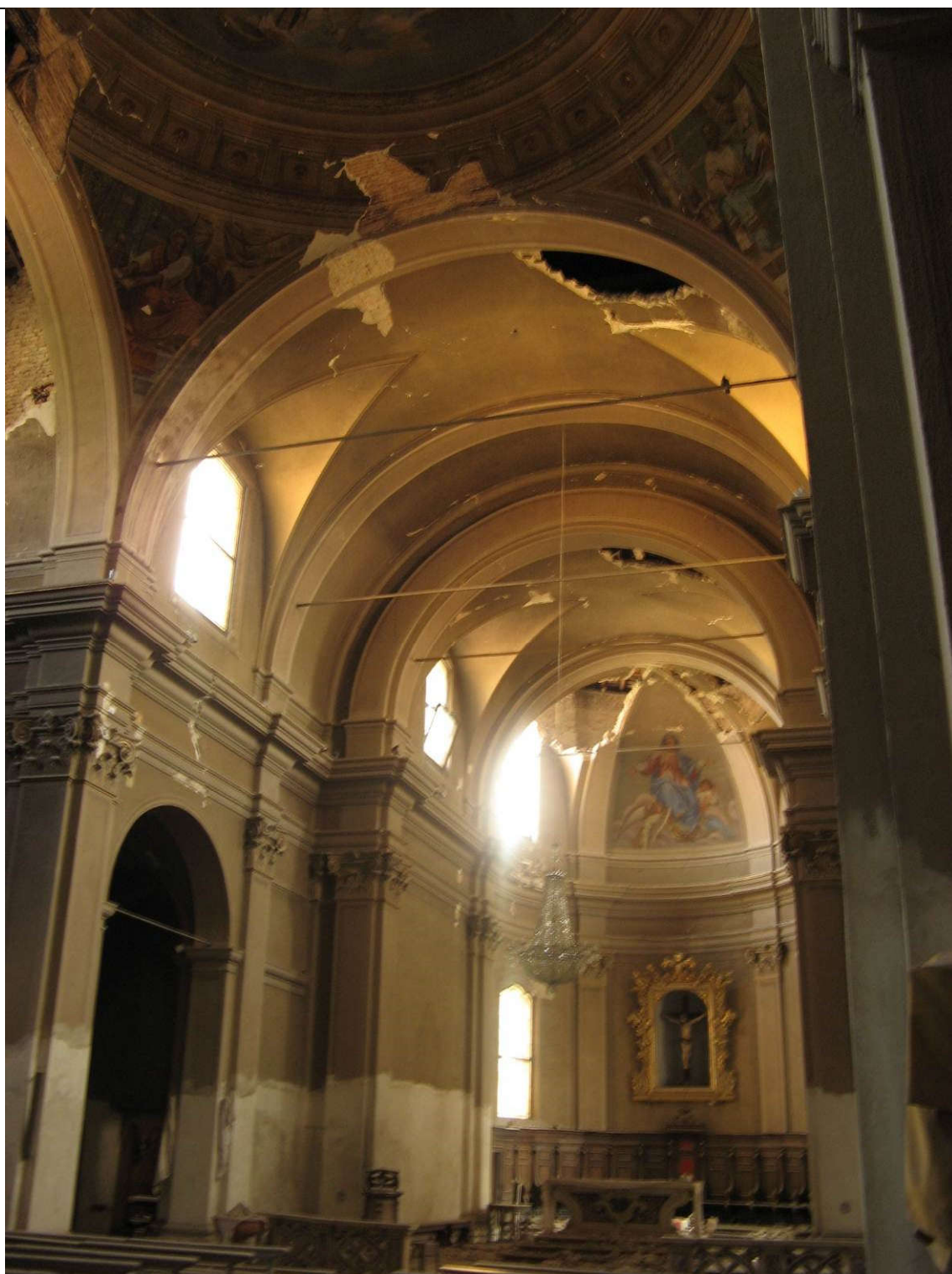
Vista generale dei danneggiamenti nella zona presbiterio-abside
