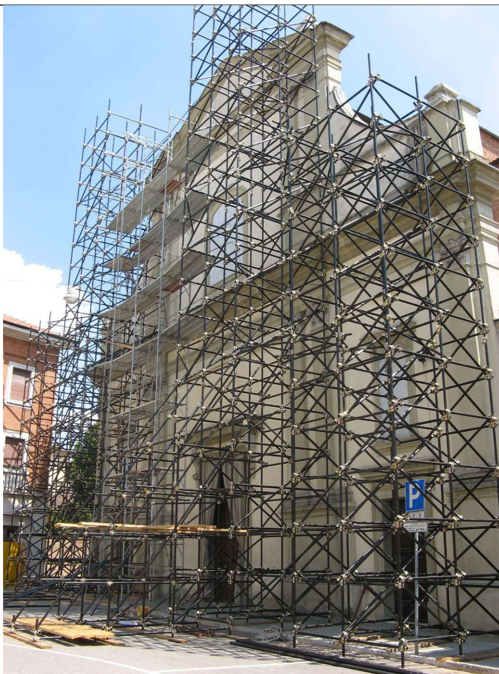
Vista generale delle opere di messa in sicurezza in facciata
