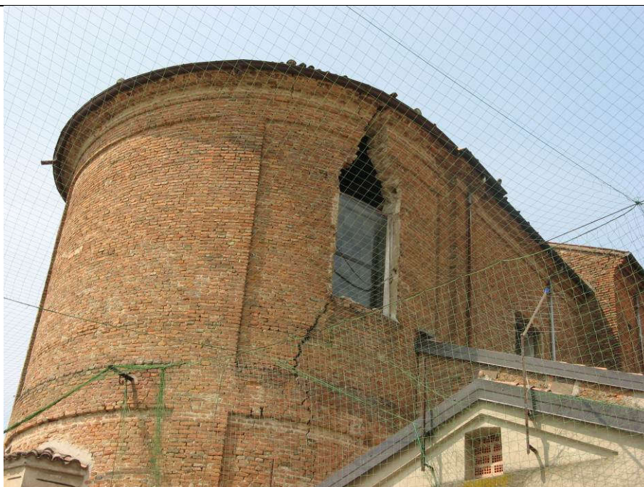
Crollo parziale dell'architrave dell'abside, lato nord
