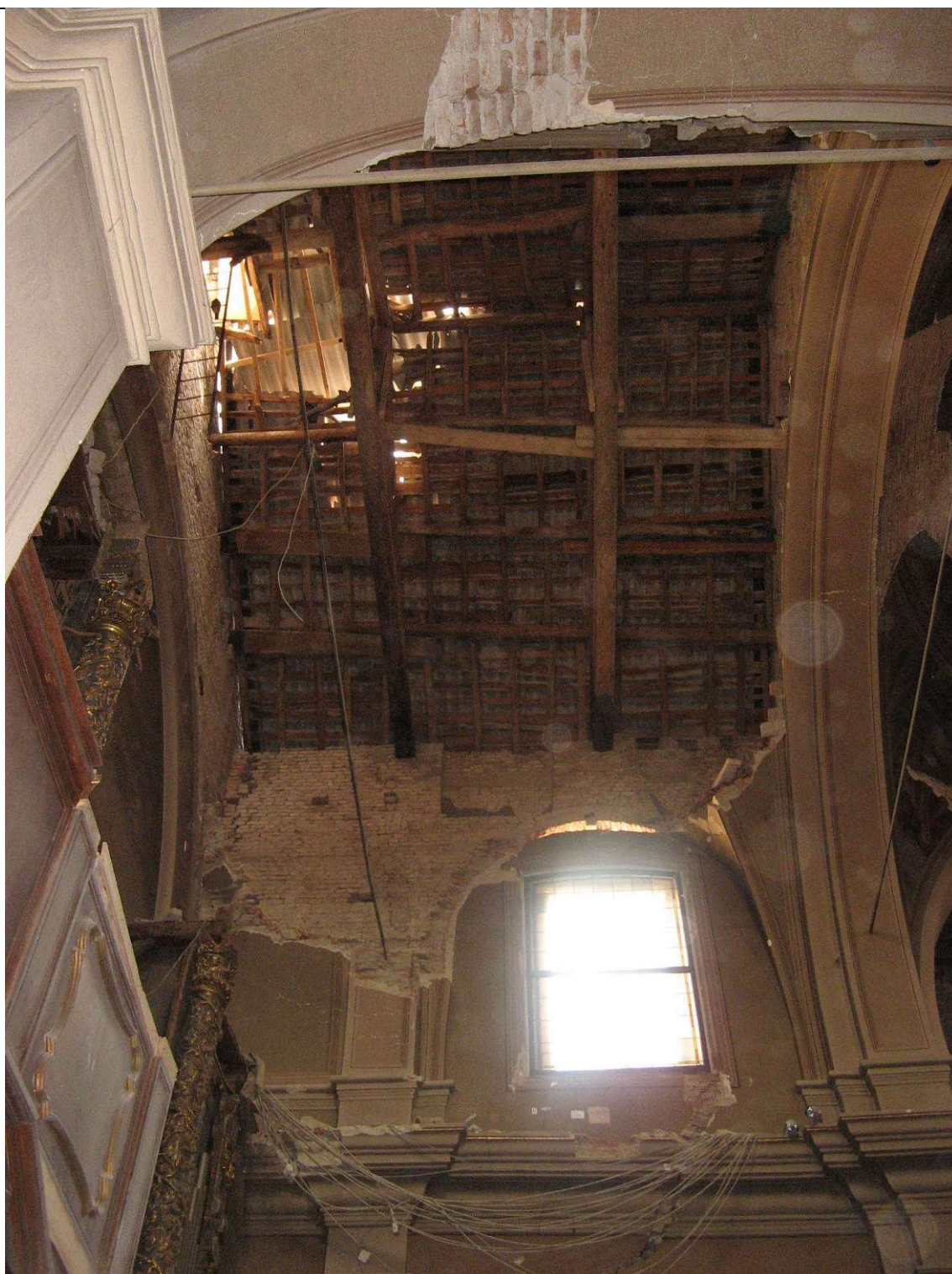
Crollo della volta di facciata
