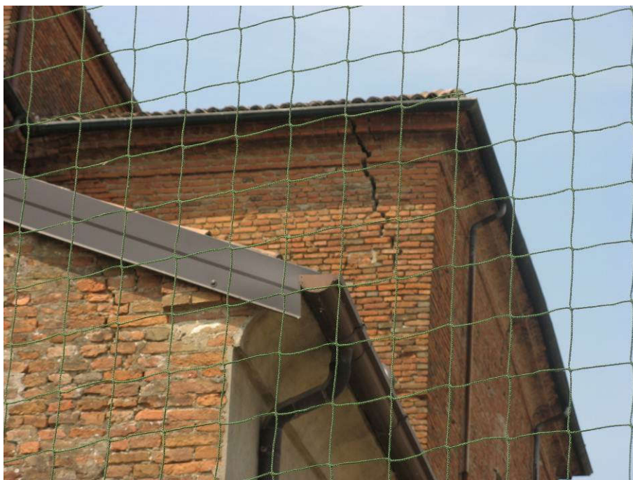
Lesione nello spigolo del transetto, lato nord
