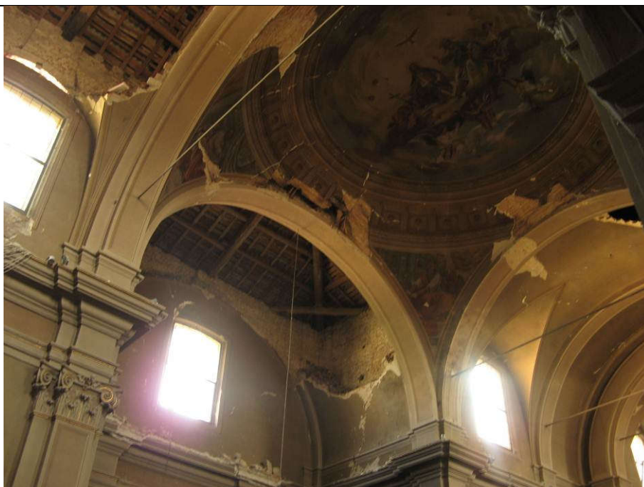
Crollo volta transetto nord, danneggiamento cupola centrale
