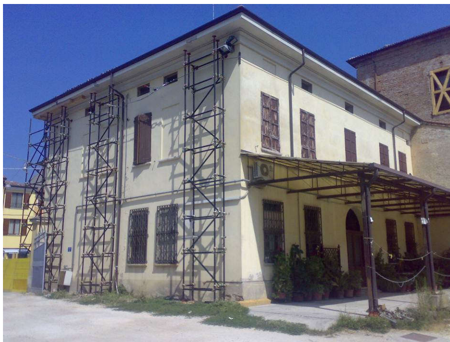
Puntellazione del cornicione della canonica
