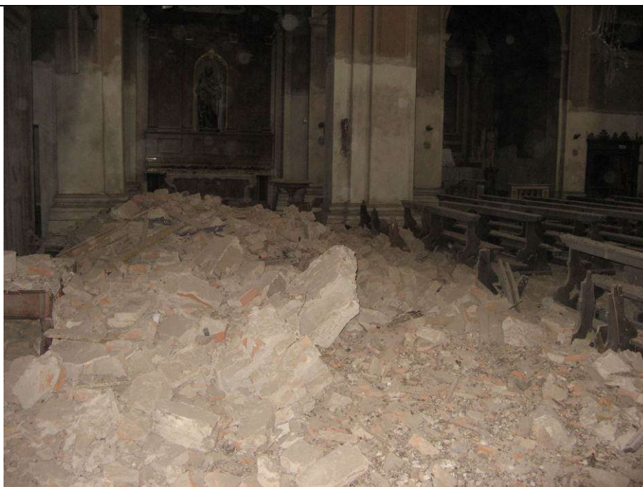
Macerie in corrispondenza del crollo della volta di facciata
