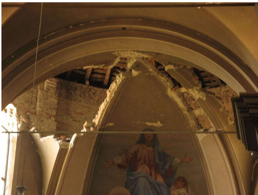
Crollo parziale della volta dell'abside
